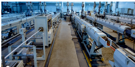
Крупнейший в России трубный цех по производству полипропиленовых и полиэтиленовых труб для систем отопления, водоснабжения
