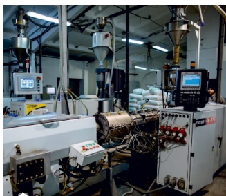
Цех по производству канализации
